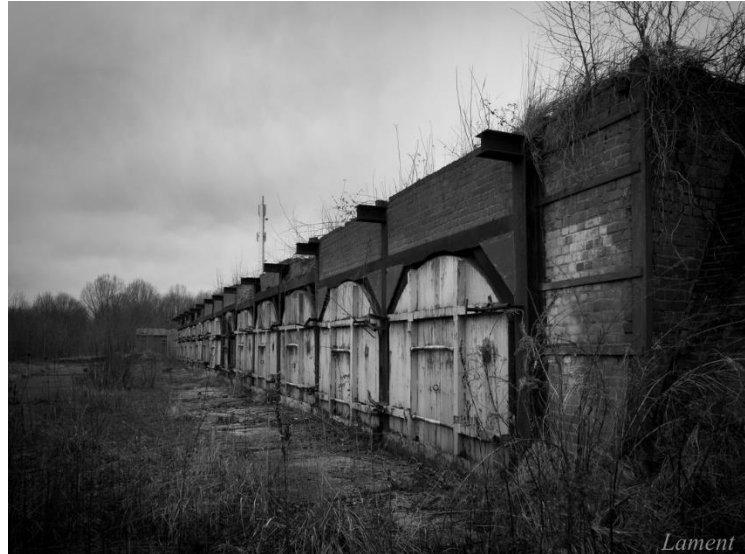
Figuur 1: Steenfabriek de Koppenwaard (Lament, 2015)
